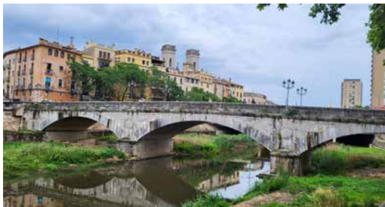
Pont de Piedra-Gerona.
