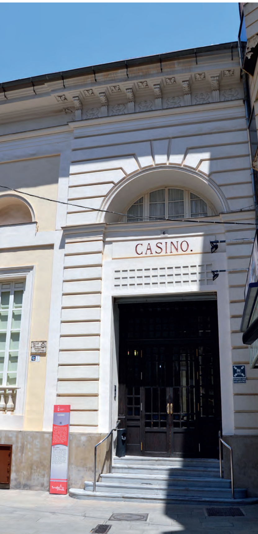
Actual fachada lateral del Real Casino, donde se conserva la original del siglo XIX.
